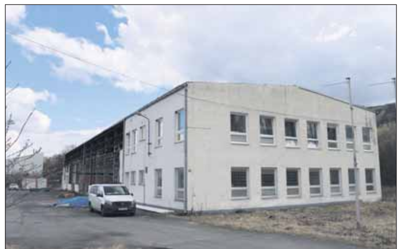
Po komplexní rekonstrukci bude tato budova sloužit profesionálním hasičům požární stanice Sušice Hasičského záchranného sboru Plzeňského kraje.
