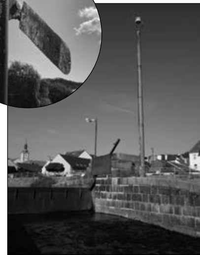
Celkový pohled na propust.
