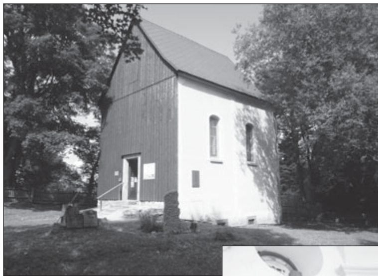
kaple Svatého Kříže po rekonstrukci
