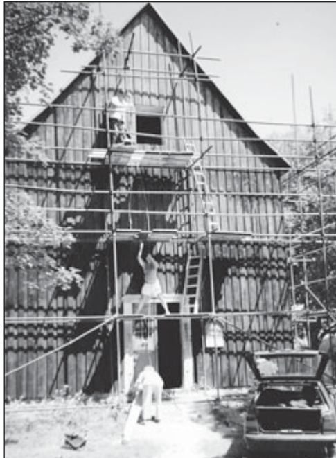
instalace zvonu Porozumění
