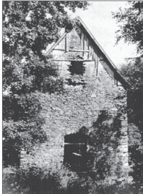
kaple Svatého Kříže před rekonstrukcí
